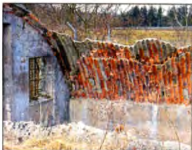
Gewölbeaufbau einer Tonröhrenunterkunft. FOTO BLFD
