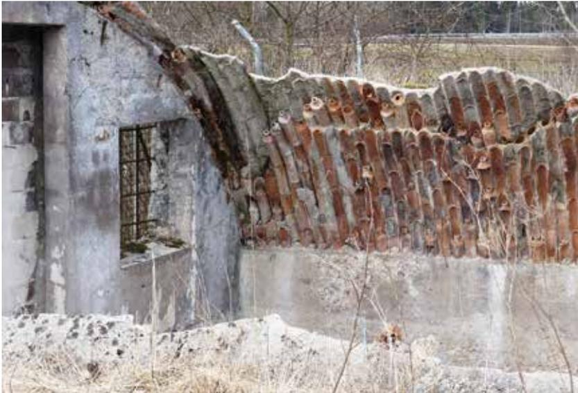
Die Ruine eines der Tonröhrenbauwerke; deren Bauweise wird hier ersichtlich
