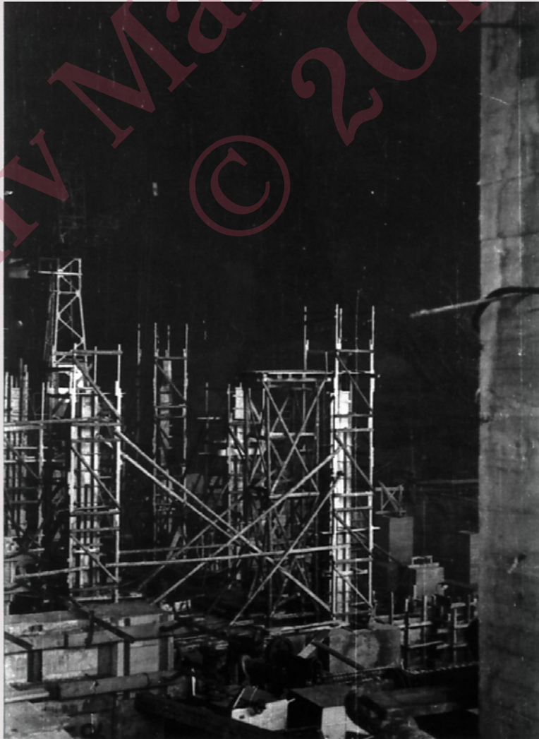
Stützen im Presse-Teil.
