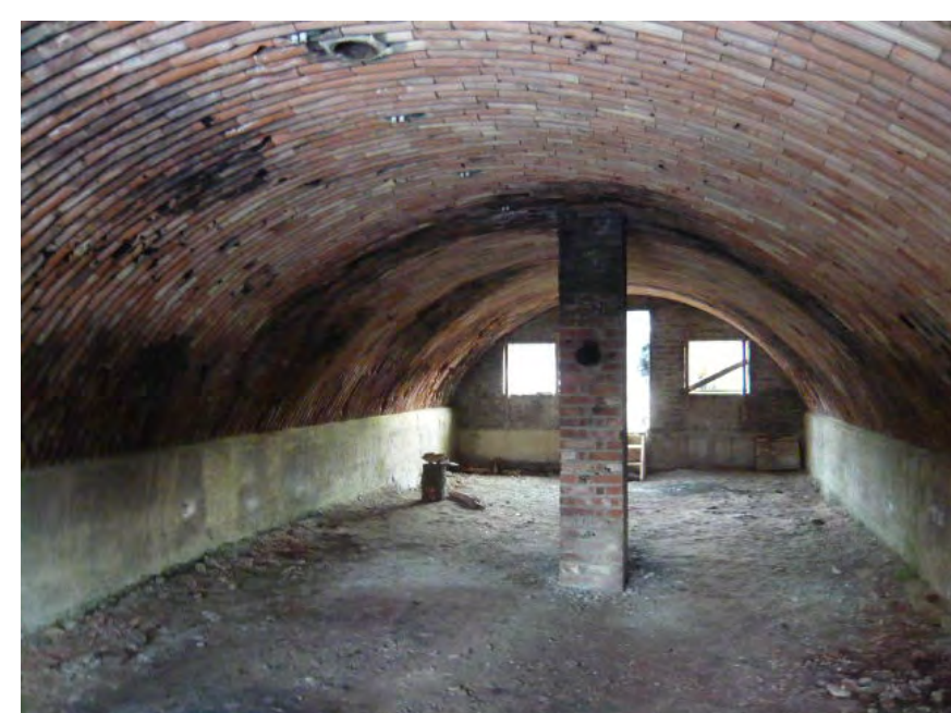
Tonröhrenbauwerk 4 vor der Instandsetzung Abb. 04 Fotoansicht 10.02.2011 innen
