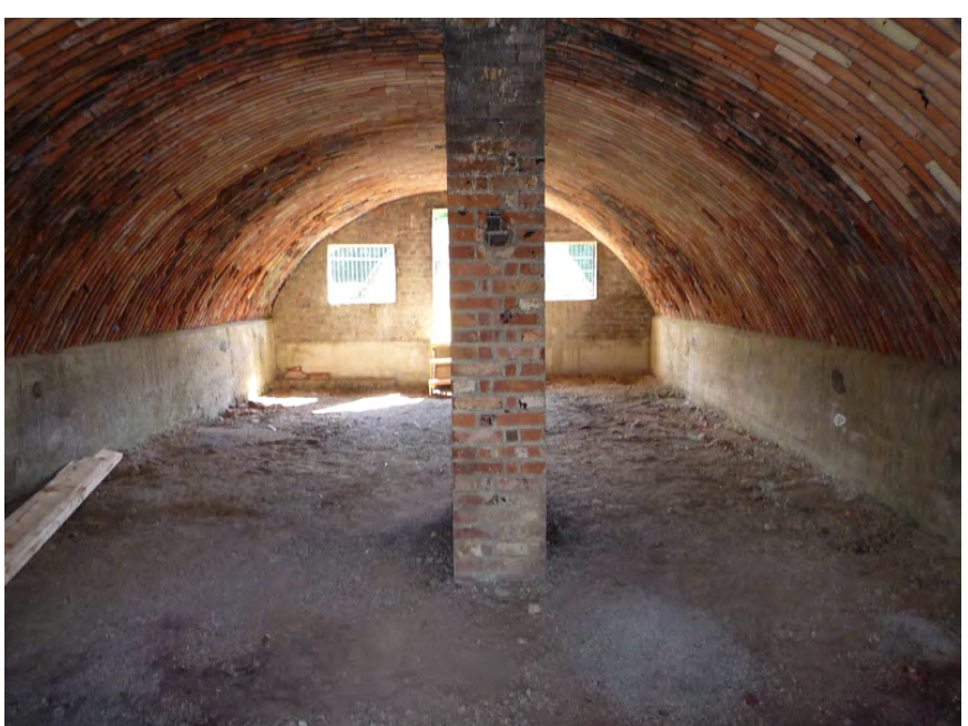
Tonröhrenbauwerk 4 nach der Instandsetzung innen Abb. 05 Fotoansicht 18.08.2014 innen
