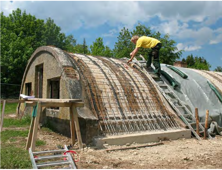
Tonröhrenbauwerk 4 Bewehrung für Aufbetonschale Abb. 16 Fotoansicht 16.05.2014 von außen
