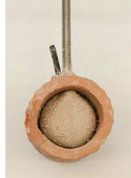
Tonröhrenverdübelung mit Gewindestange, Füllschlauch und Ankerstrumpf Abb. 21 Detailansicht 17.11.2015
