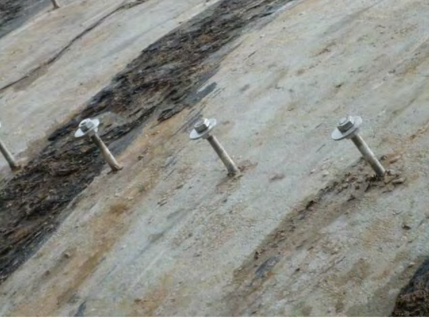
Tonröhrenverdübelung für Aufbetonschale Bauwerk 4 Abb. 18 Detailansicht 13.05.2014 von außen
