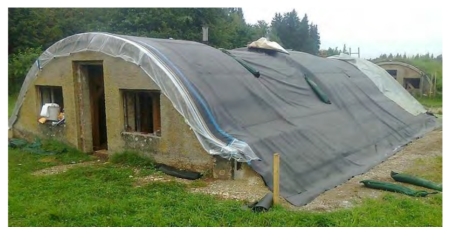
Tonröhrenbauwerk 4 Einbau der Kautschukfolienabdichtung Abb. 27 Fotoansicht 01.08.2014 von außen
