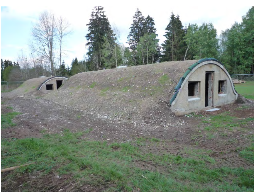
Tonröhrenbauwerk 2+3 nach Instandsetzung und Wiederverfüllung Abb. 03 Fotoansicht 24.09.2015 von außen
