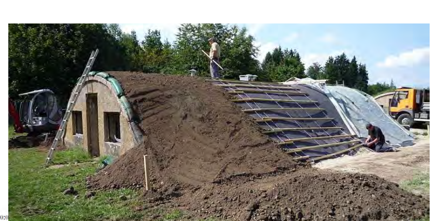
Tonröhrenbauwerk 4 Wiederverfüllung mit Abrutschsicherung Abb. 28 Fotoansicht 06.08.2014 von außen
