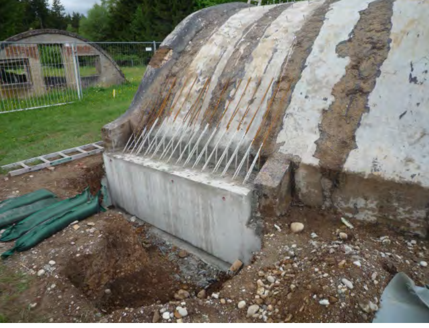
Tonröhrenbauwerk 4 Neufundierung für Aufbetonschale Abb. 17 Fotoansicht 13.05.2014 von außen
