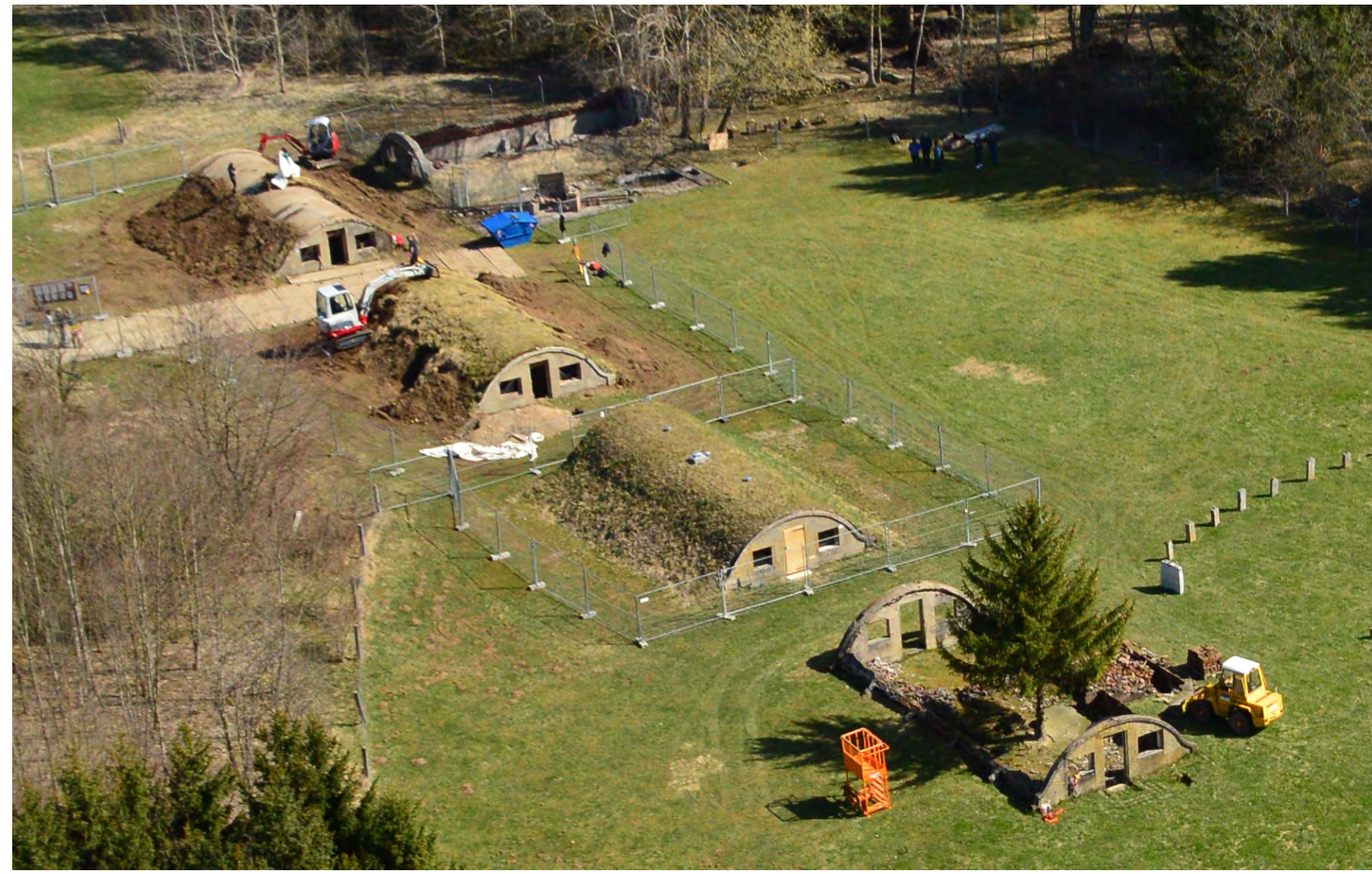
Geländeansicht während der Bodenabgrabung der Tonröhrenbauwerke 2 und 3 Abb. 01 Drohnaufnahme 10.04.2015
