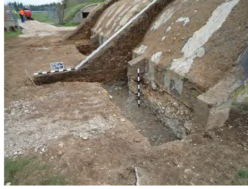
Fundamentmauer Tonröhrenbauwerk 4 gegen Erdreich betoniert Abb. 14 Detailansicht 10.04.2014 von außen
