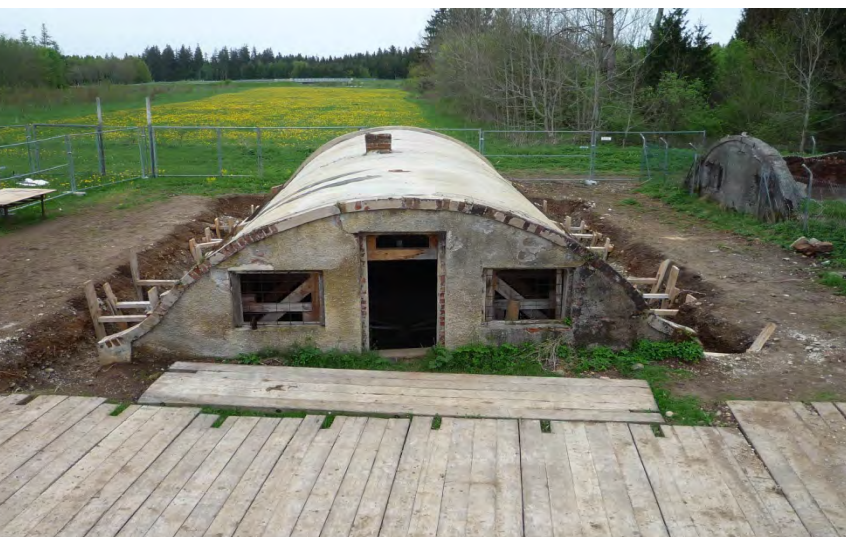
Tonröhrenbauwerk 2 Neufundierung für Aufbetonschale Abb. 24 Fotoansicht 05.05.2015 von außen
