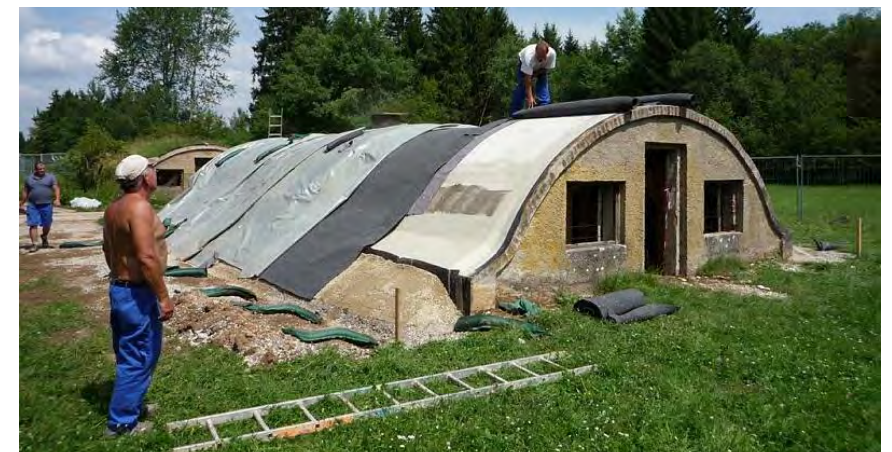
Tonröhrenbauwerk 4 Einbau der Kautschukfolienabdichtung Abb. 26 Fotoansicht 28.07.2014 von außen
